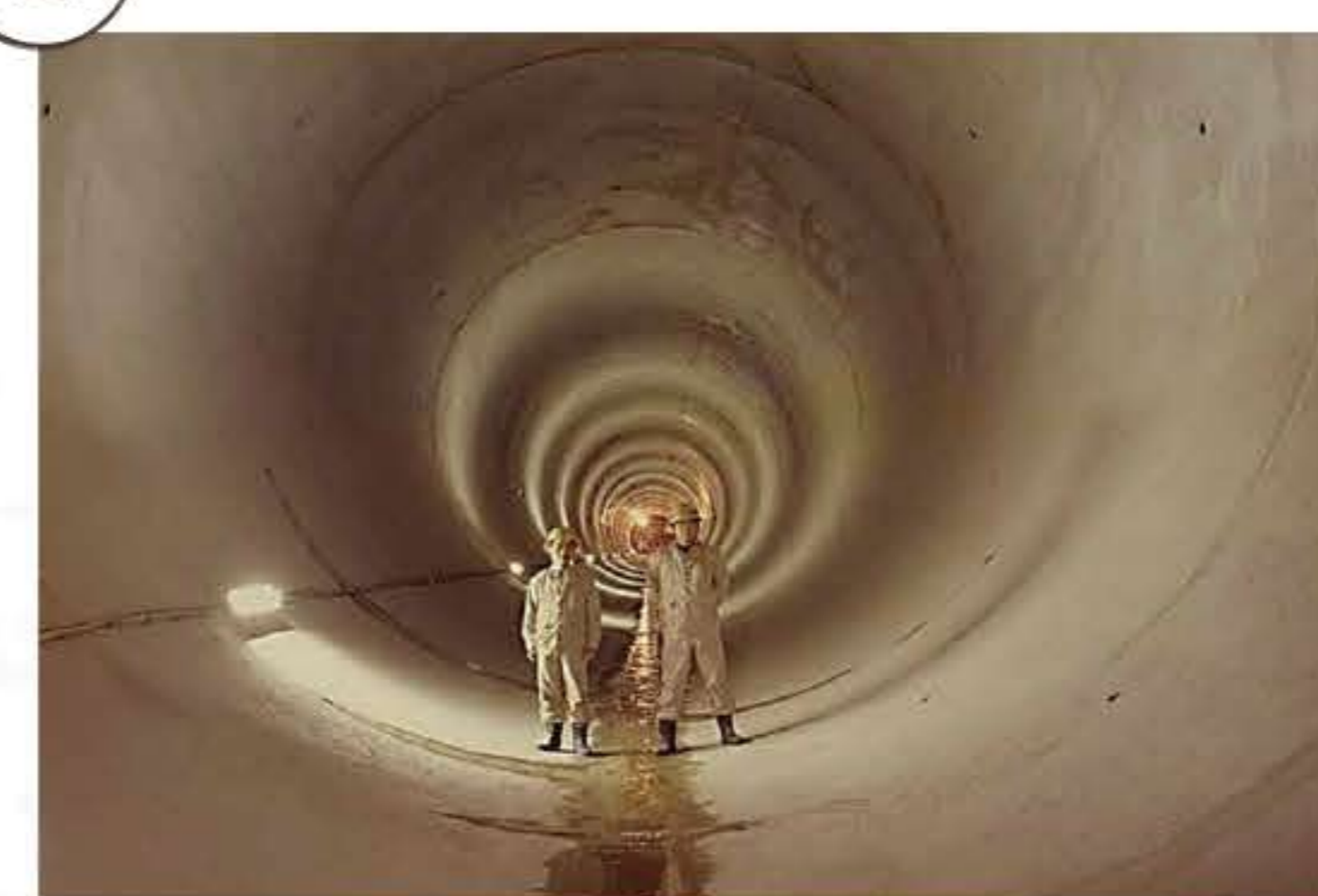
3 奥矢作第一・第二発電所 導水路トンネル
